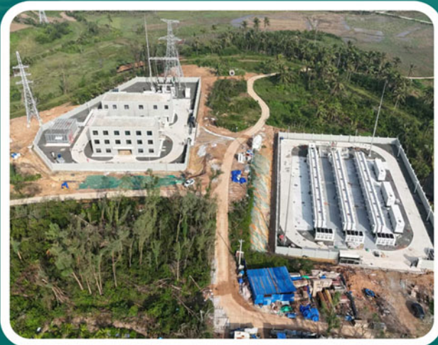
金盘海口甲子100MW农光互补光伏发电项目
