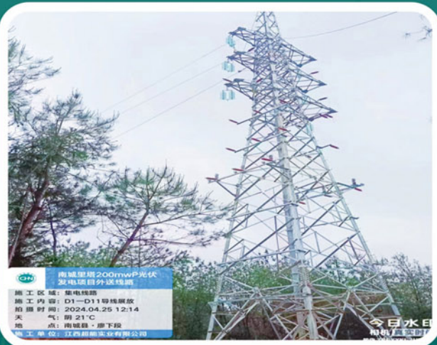
风电光伏中国电建抚州南城县里塔镇一期 200MWp光伏发电项目
