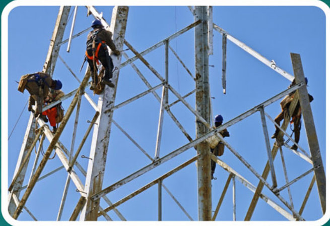
中广核鄱阳500MW农（林、渔）光互补光伏一期250MW项目（在建）
