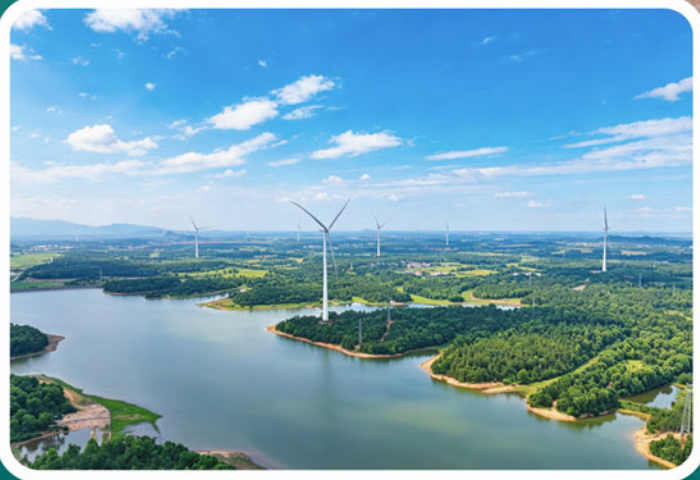
奉新赤岸80MW风电项目
