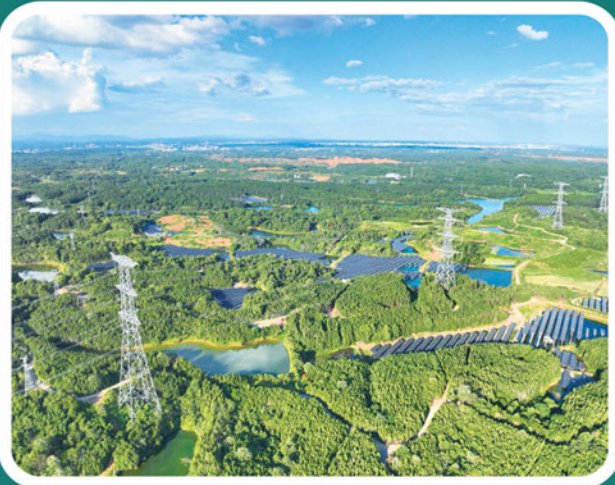
宜丰润时新能源石市镇50MW光伏发电项目
